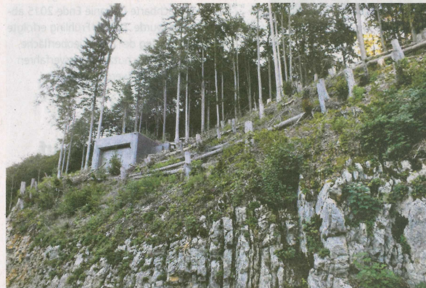
Unweit der aktuellen Holzfäll-Arbeiten ist aus früheren Arbeiten dokumentiert, wie der Wald – mit Querfällungen – dereinst aussehen wird.
