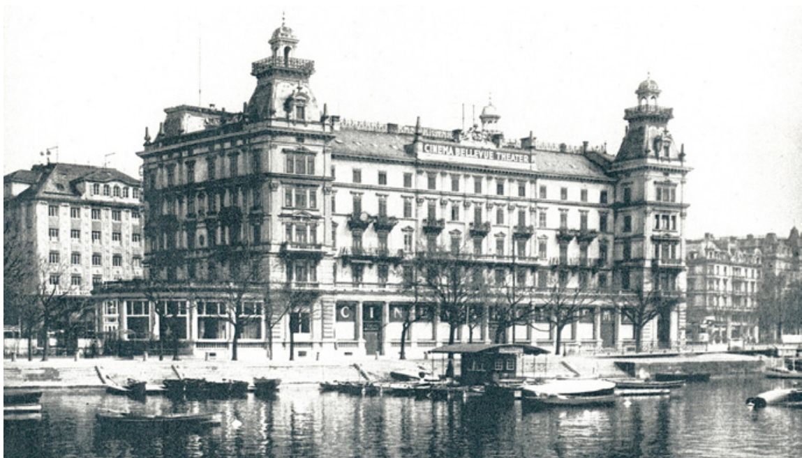
Bild 56: Ehemaliges Hotel «Bellevue au Lac»; um 1915; l. im Parterre das halbrunde «Carlton». Die oberen Stockwerke wurden in den späteren 1910er-Jahren zu Wohn- und Büroziwecken an Private vermietet. Lenys Wohnzimmer lag im obersten Stockwerk (Foto zVg Baugeschichtliches Archiv, Stadtarchiv Zürich).
